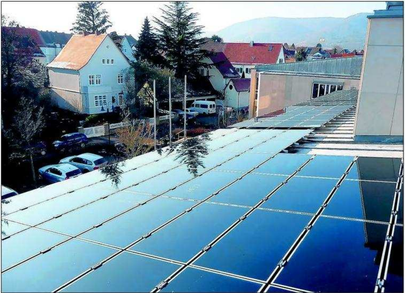
Das Dach der VG-Verwaltung in Edenkoben ist bereits großflächig mit einer Solaranlage ausgestattet. Weitere öffentliche Gebäude werden im Laufe des Jahres folgen; so wurde bereits damit begonnen, die Dächer des Pamina-Schulzentrums in Herxheim mit Modulen auszurüsten. FOTO: PRIVAT
