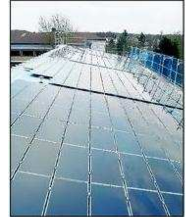
Großflächig wurde das Dach des Pamina-Schulzentrums mit einer Fotovoltaikanlage ausgestattet.
