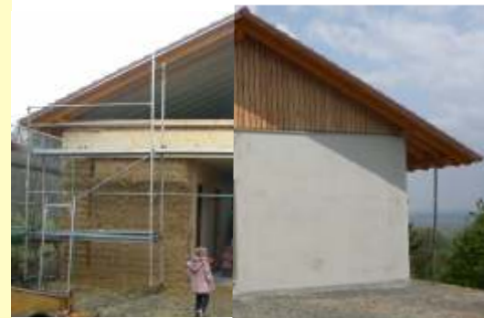
Strohenergiegewinnhaus links im Rohbau, rechts im Ausbau Foto: Karayel
